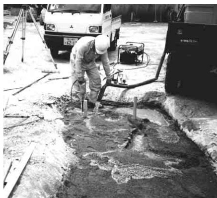
写真2 試験施工状況（二層目の水締め） Photo 2 Experiment work (Hydraulic filling at second layer)
