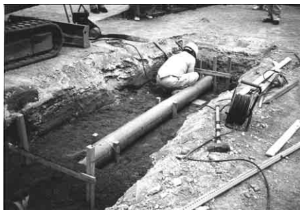
写真1 試験施工状況（一層目の施工） Photo 1 Experiment work (Work of first layer)
